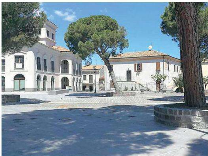
Piazza Calabresi dopo i lavori di riqualificazione
