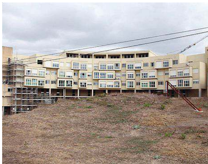
L'area sulla quale sorgerà la Rsa di Macomer (foto Moscatelli)
