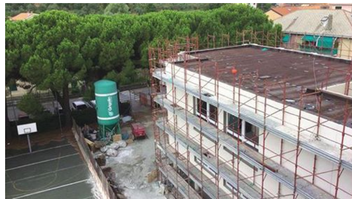
Marco Garibaldi IMPIANTI A NORMA accessibili per tutti alla Descalzo
