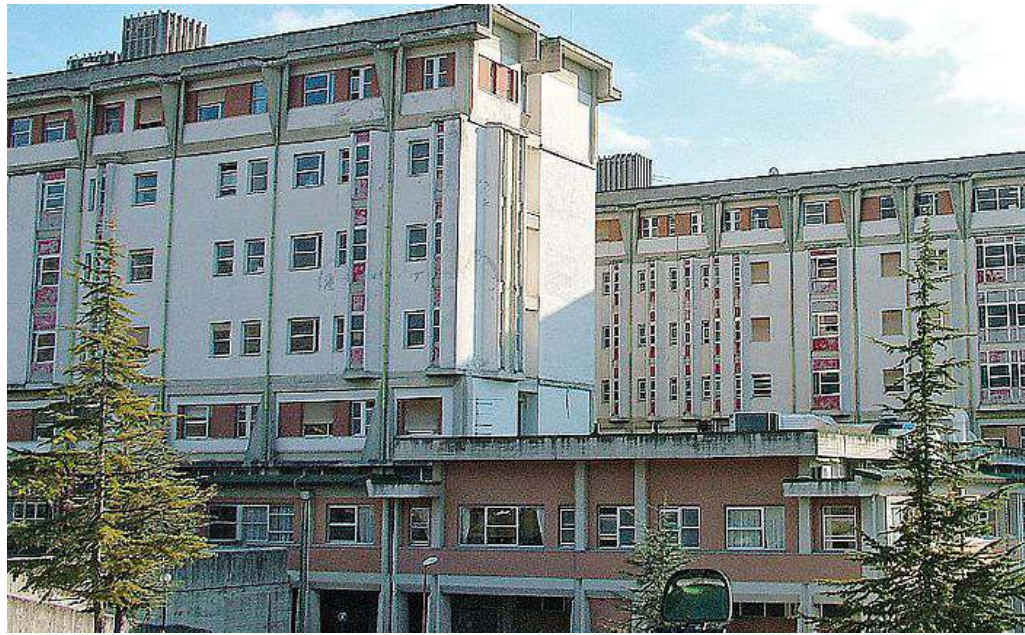
All'ospedale di Avezzano è stato trattato il caso del trentenne morso da un ragno
