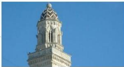
Particolare della parte terminale della Guglia
