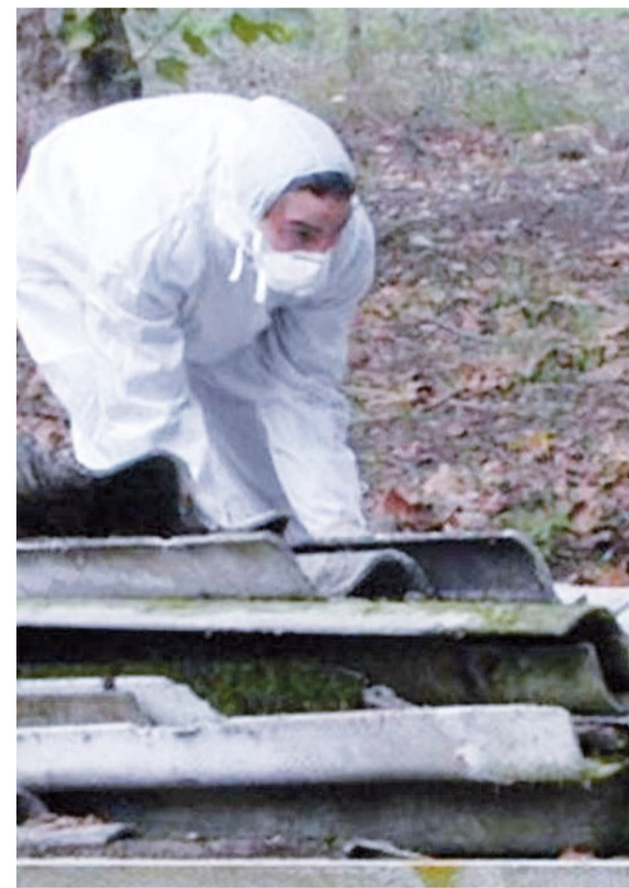
Rimozione di lastre d'amianto
