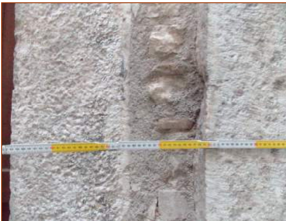
Fig.4. Differenze nella lavorazione della pietra tra stipiti di portali: in quello di destra (portale centrale del prospetto principale) si evidenzia una rifinitura eseguita a bocciarda a maglia fine.
