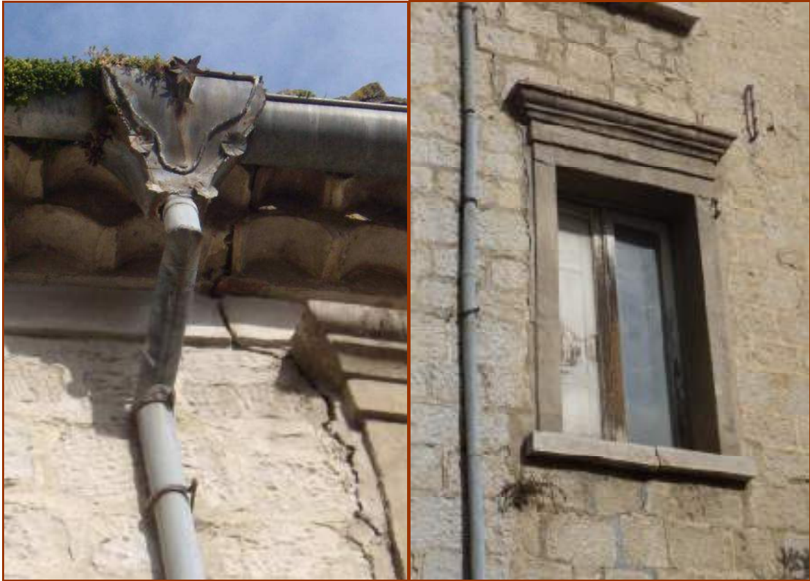
Fig.2. Particolare di grondaia e di finestra con tracce di lesioni sulla mensola
