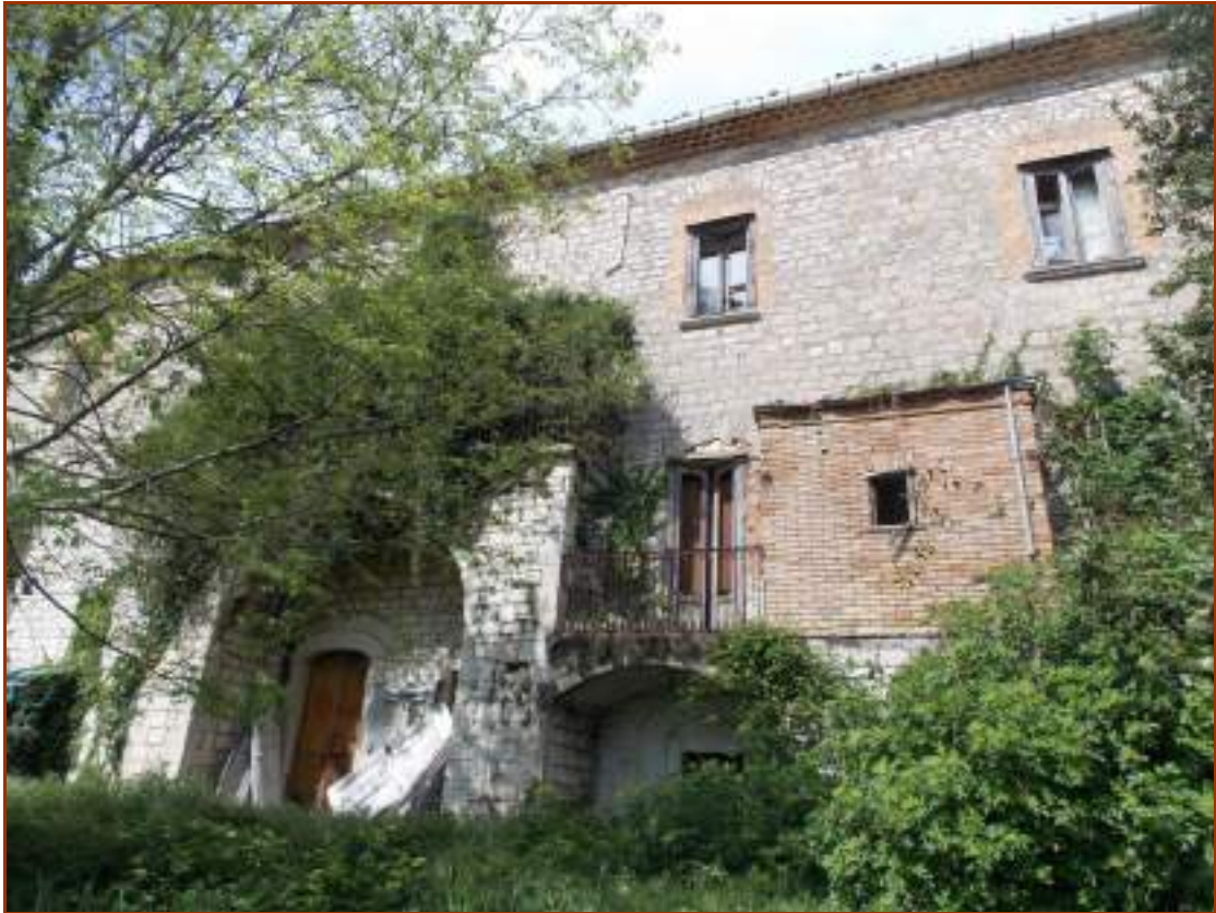
Fig.5. L'articolato e movimentato prospetto sud, con corpo laterizio sporgente
