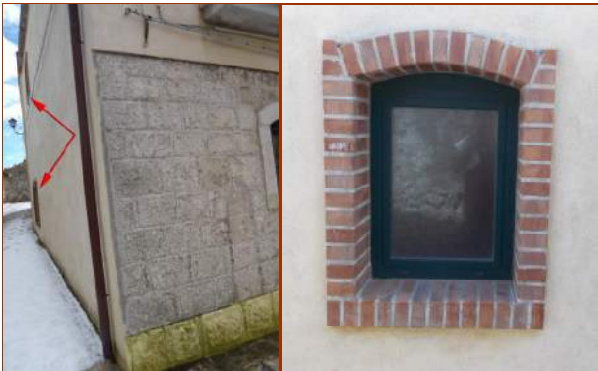
Fig.3. In giallo è evidenziato il primo filare di pietre lavorato "a bugnato", mentre con le frecce rosse si indicano le finestre risagomate con il laterizio. A destra particolare delle stesse.
