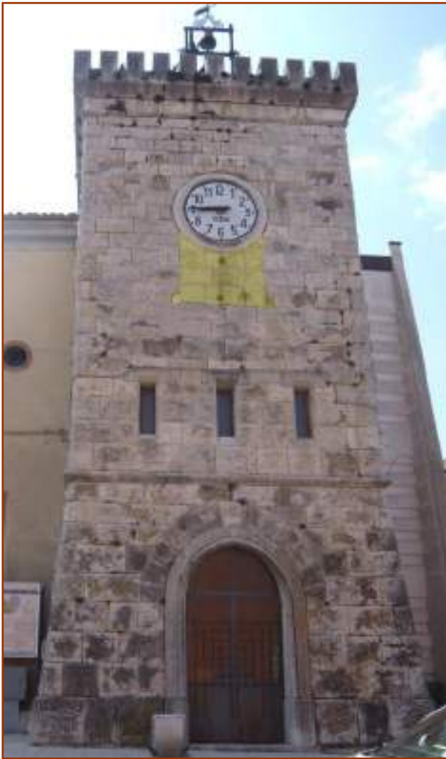
Fig.3. la torre con l'orologio. In giallo il tamponamento di una precedente apertura
