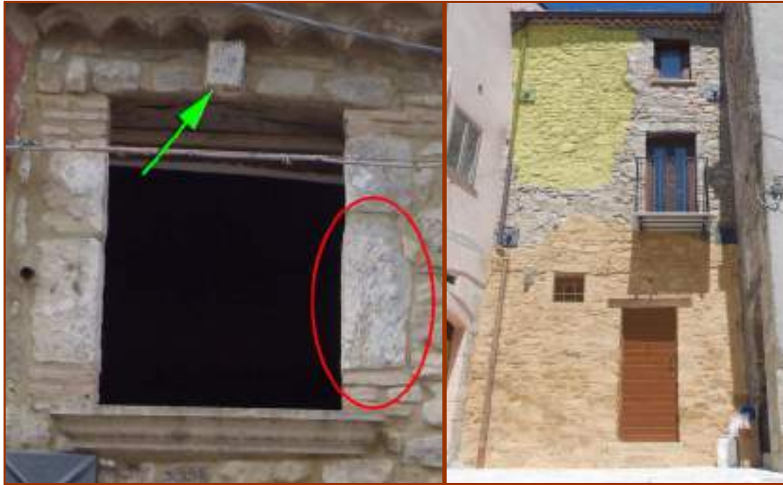
Fig.4. Foto di sinistra: con il cerchio rosso si evidenzia la pietra mostrante piccoli rilievi paralleli attribuibili alle tracce fossilizzate di una frana sottomarina. Con la freccia verde viene indicato il laterizio decorativo colorato di bianco. Foto di destra: con il colore giallo si evidenzia una ritessitura localizzata del paramento murario, che potrebbe solo coinvolgere la trama muraria più esterna, mentre con l'arancio si evidenzia un muro a scarpa successivamente addossato ai muri più vecchi.
