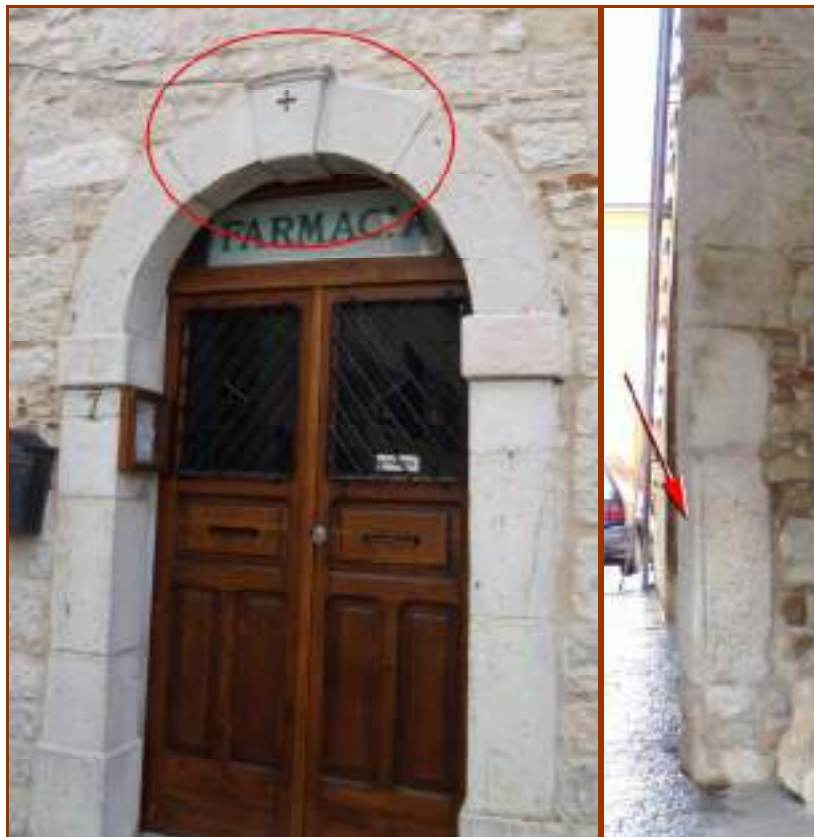
Fig. 3. (da sinistra verso destra). Portale datato 1877 con evidenziato il blocco lapideo con la chiave di volta. A destra la freccia rossa indica un elemento lavorato con rifiniture identiche a quelle degli stipiti della monofora della chiesa
