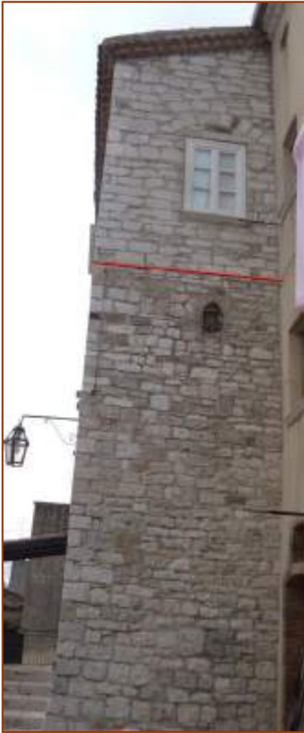
Fig.4. La linea rossa indica due fasi edilizie differenti, caratterizzate da un diverso uso della pietra
