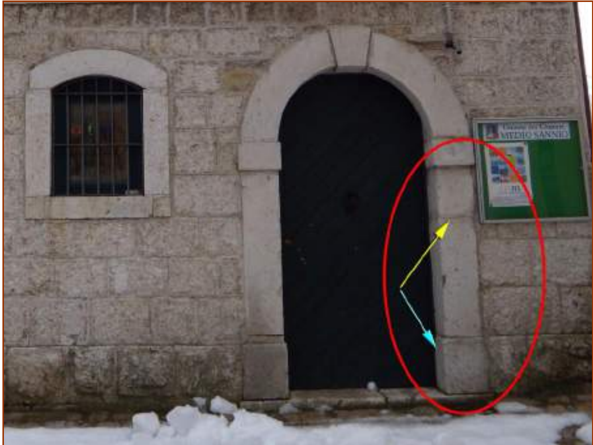
Fig.2. dettaglio della facciata con il portale e la finestra in pietra. Con il cerchio rosso si identifica lo stipite destro che pare reintegrare elementi più antichi. La freccia gialla indica una frattura trasversale del piedritto mentre con la freccia azzurra si identifica il dado d'imposta, che ha differenti modanature rispetto al suo corrispettivo di destra.
