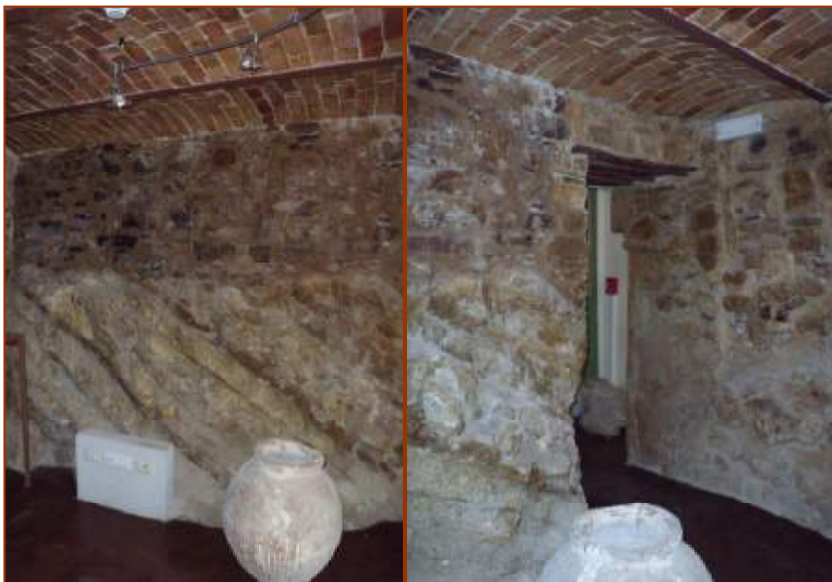
Fig.5. Alcuni dettagli dei seminterrati, con stratificazioni calcaree in vista e muri in sasso direttamente appoggiati sopra
