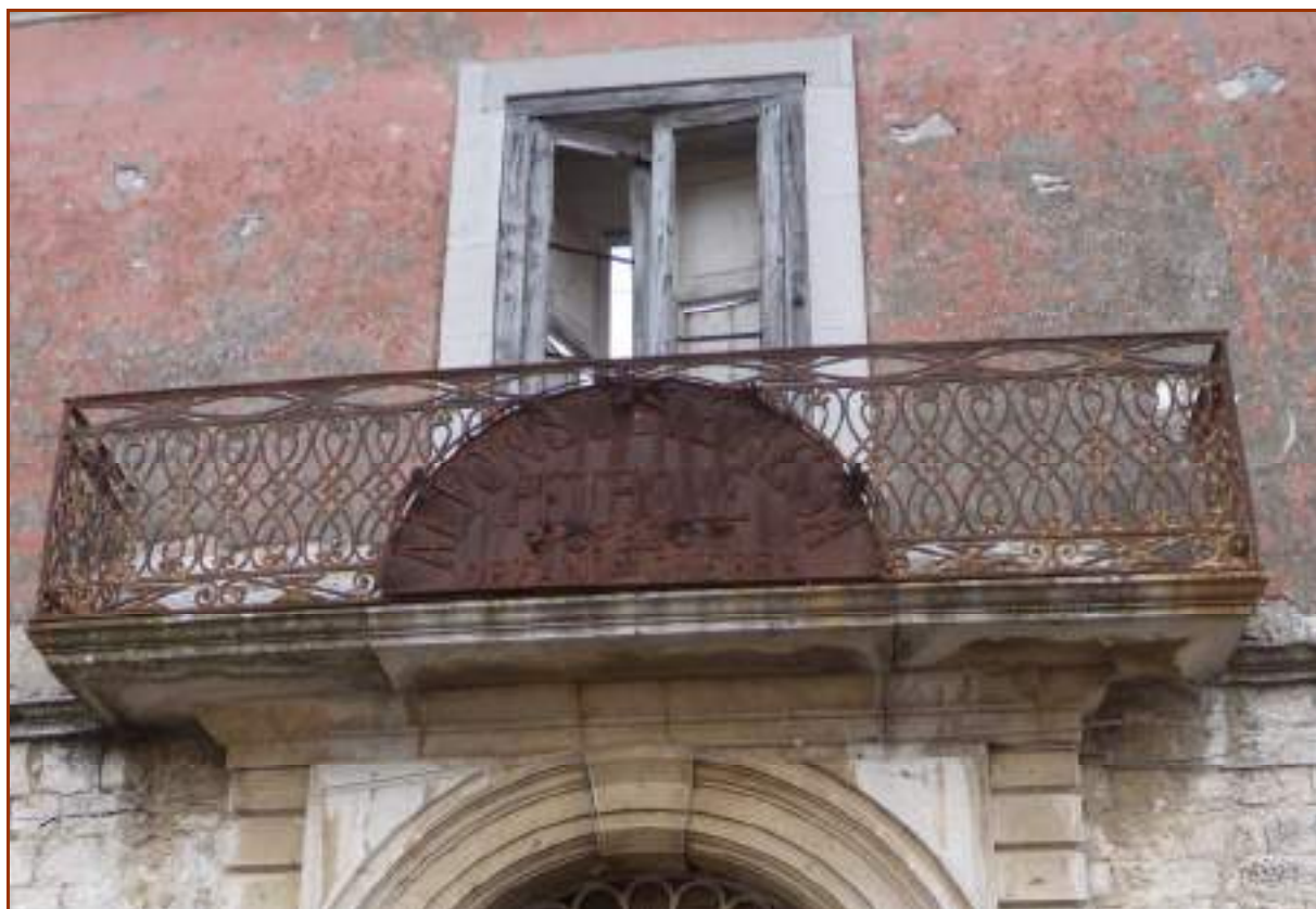
Fig.2. il balcone in ferro lavorato
