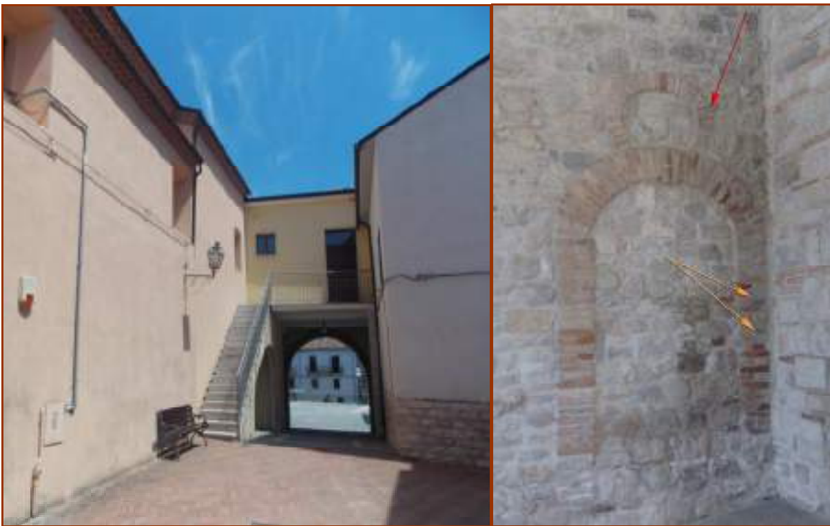
Fig.4. A sinistra particolare del cortile interno, mentre a destra il portali in mattoni con indicati mediante frecce gialle alcuni mattoni nerastri ipercotti, con la freccia rossa un mattone-cerniera con la muratura adiacente.
