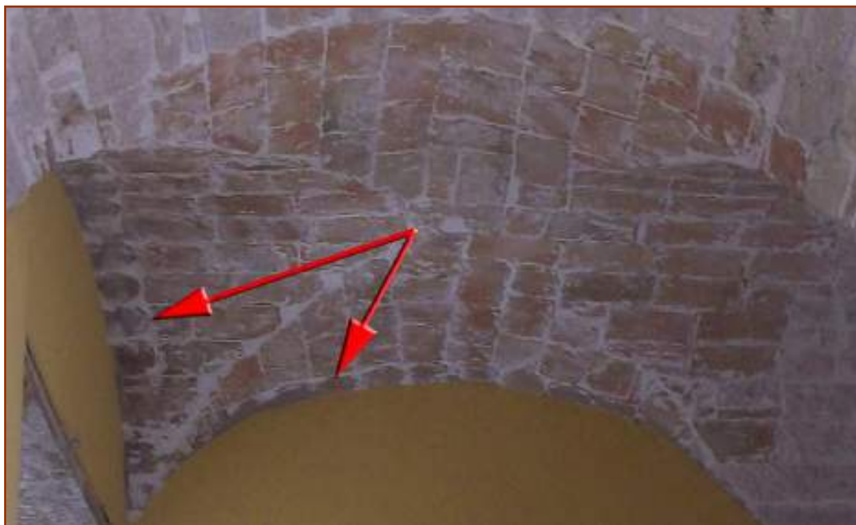
Fig.3. il soffitto voltato del vano scala per accedere ai piani superiori dall'esterno. Le frecce rosse indicano i Pignatelli di forma circolare
