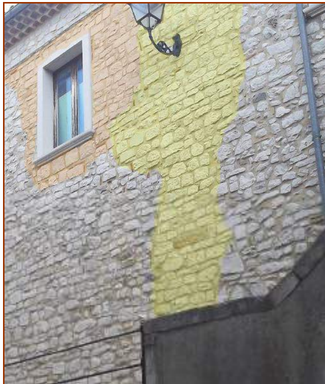
Fig.4. I colori indicano alcune ritessiture localizzate del paramento murario esterno del prospetto principale dell'edificio. Questi elementi testimoniano la lunga e travagliata storia dell'edificio
