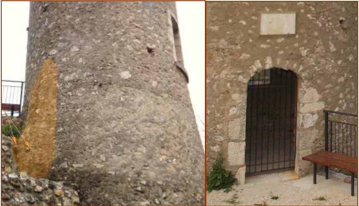
Fig.3. a sinistra con il colore arancione si evidenzia il lacerto murario che s'innesta col corpo della torre; le frecce indicano alcune "morse" lapidee. A destra dettaglio del portale d'ingresso.
