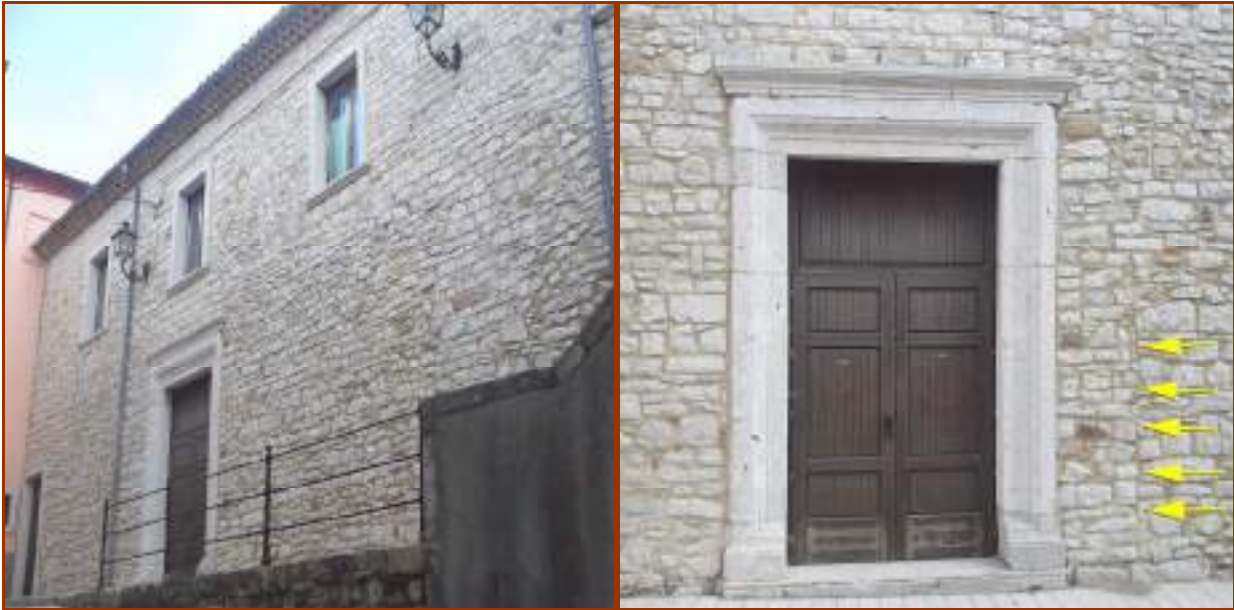
Fig.2. Il prospetto principale della ex-chiesa; a destra le linee gialle indicano una precedente soglia di un portale poi sostituito da quello attuale
