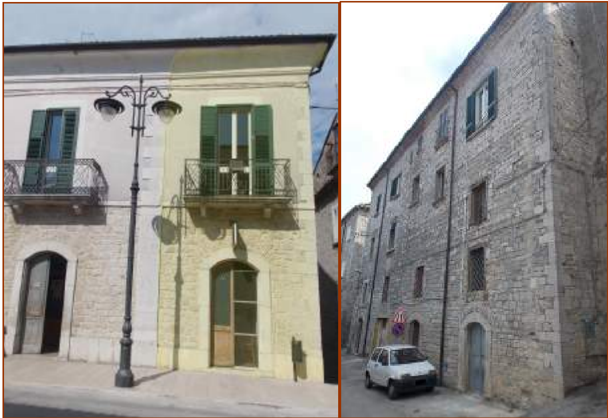
Fig.3. il presunto ampliamento in facciata, evidenziato con il colore giallo nella foto di sinistra; a destra la parte posteriore del palazzo, caratterizzata da lineamenti più “rustici”, con alternanza di pietre calcaree bianche e grigiastre, che con la loro alternanza vivacizzano gli effetti cromatici delle pareti
