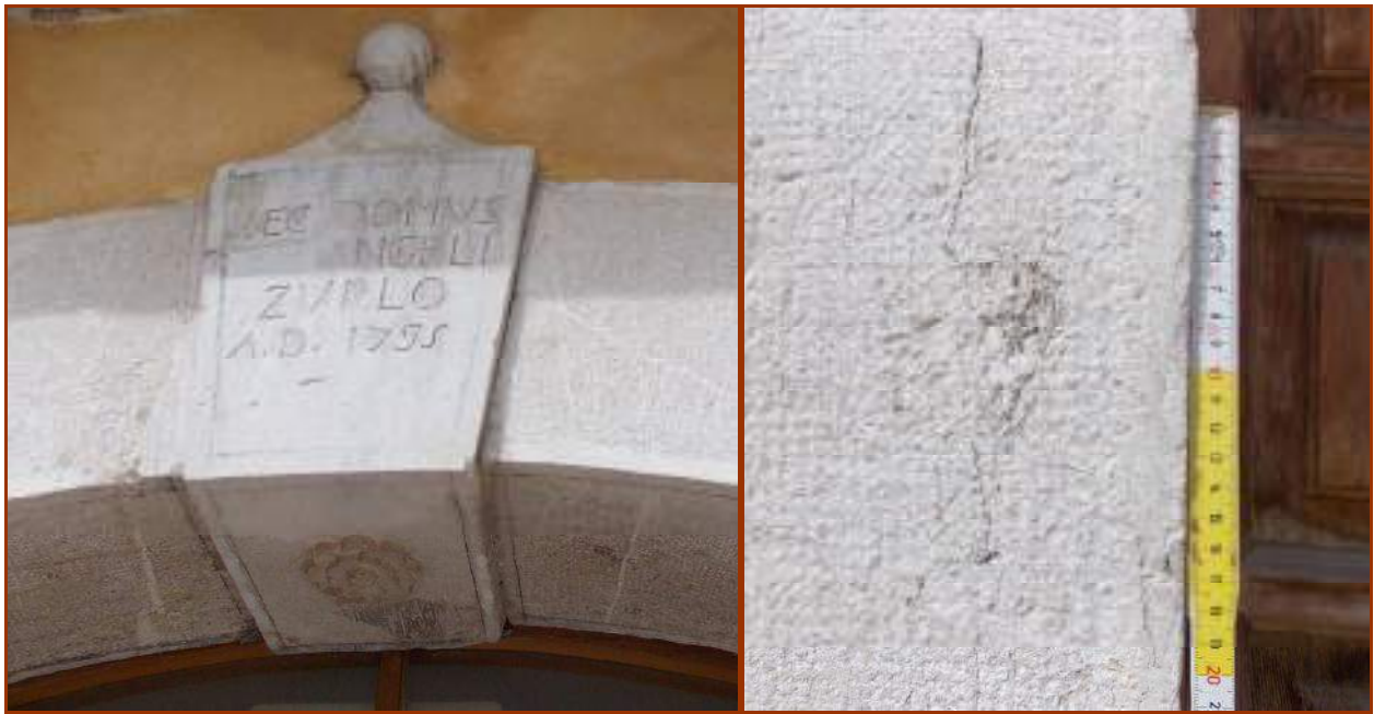
Fig.2. Iscrizione del 1795 su chiave di volta di portale; a destra particolare di stipite rifinito a bocciarda
