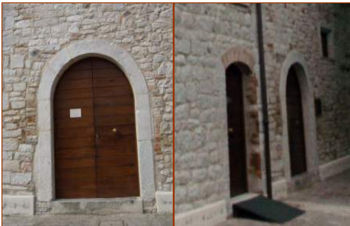
Fig.5. a sinistra ad arco con incisa data settecentesca, mentre a destra lo stesso portale affiancato dal portale più recente con archivolto laterizio
