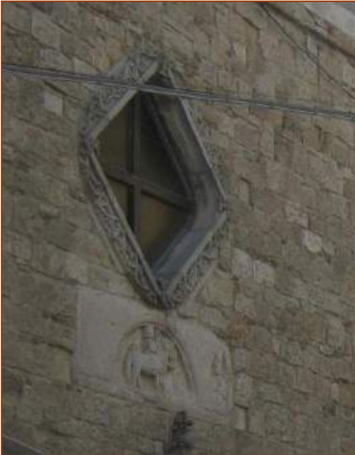
Fig.4. Particolare del bassorilievo romanico
