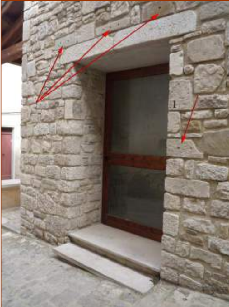
Fig.2. Un dei portali di accesso. Le frecce rosse indicano stipiti di reimpiego, caratterizzati da buchi per l'innesto d'inferriate.
