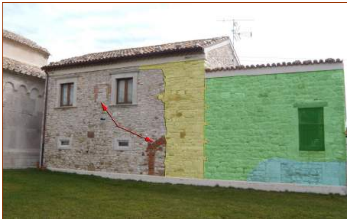
Fig. 3. Prospetto ovest. Con i colori giallo, verde e azzurro gli ampliamenti ed i rifacimenti subiti dall'edificio; con le frecce rosse si indicano le aperture più antiche in laterizio.
