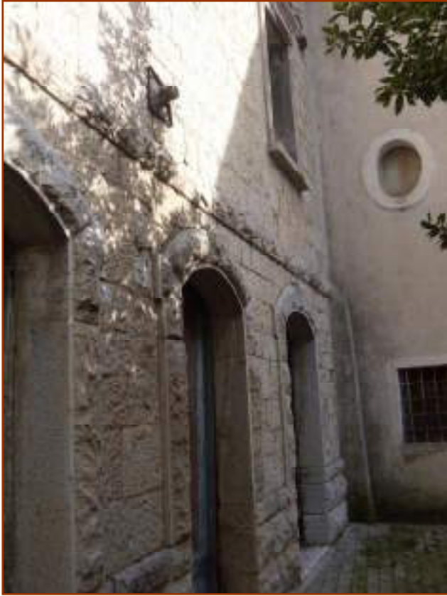
Fig.3. particolare del bugnato
