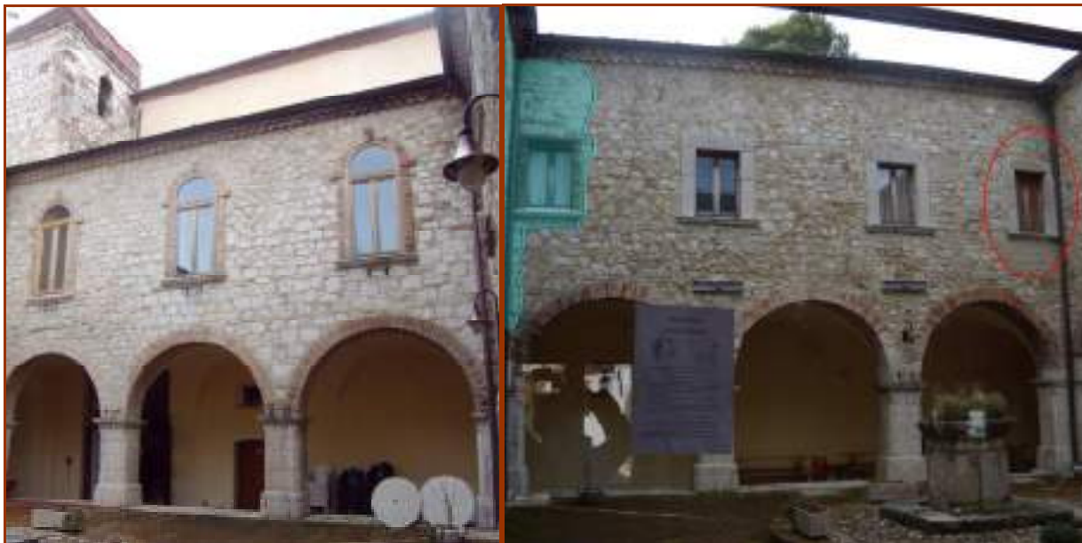
Fig.3. a sinistra la fase muraria del cortile con il muro in pietra a vista più recente. A destra il prospetto più antico; con il colore azzurro la fase più recente si “appoggia” ai muri più vecchi. Con il cerchio rosso si evidenzia una finestra con inciso una croce benaugurale sull’architrave.
