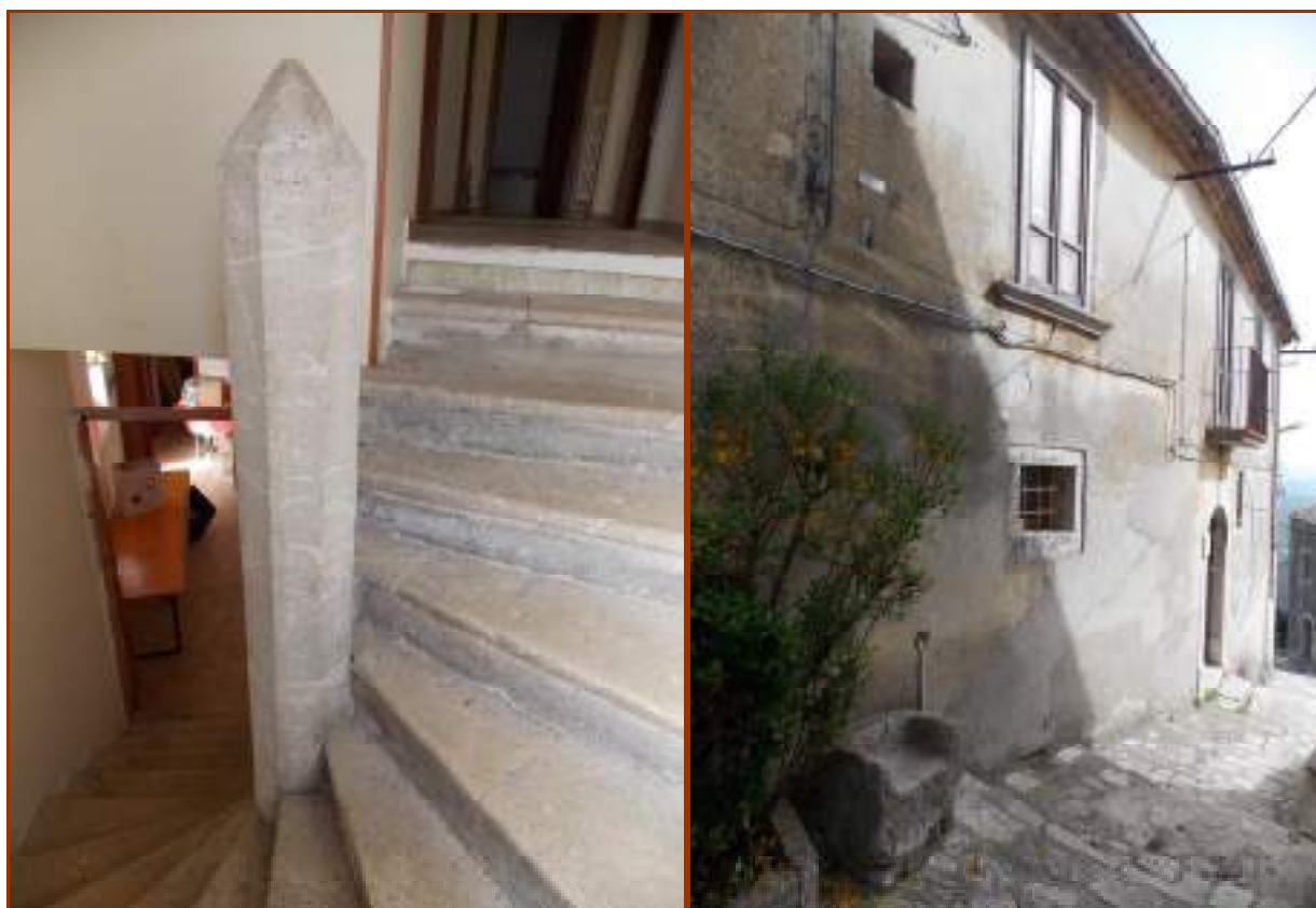
Fig.3. dettaglio della scala interna e prospetto principale dell'edificio, con in primo piano l'antico manufatto
