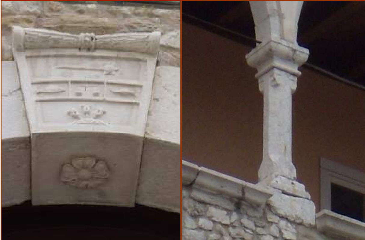
Fig.2. a sinistra particolare della chiave di volta del portale d'accesso; a destra una delle colonnette della loggia
