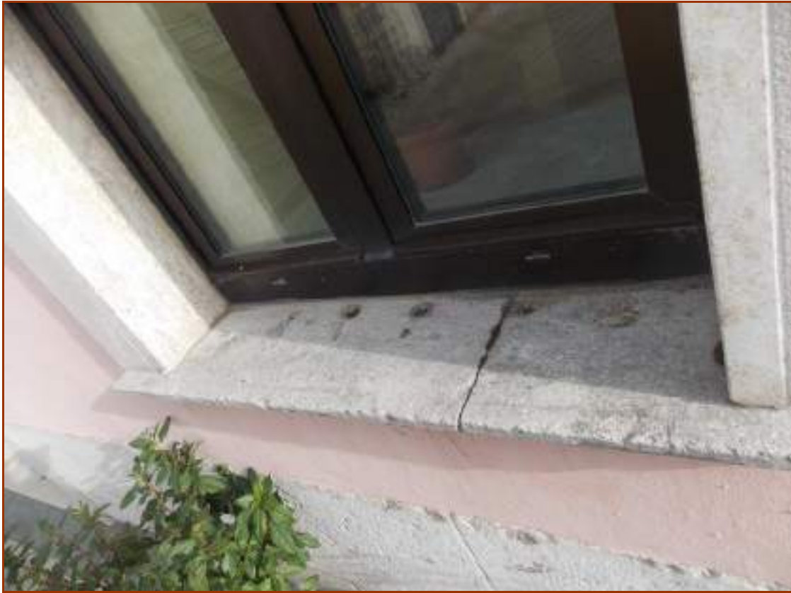
Fig.3. Dettaglio del davanzale di una delle finestre in facciata, con buchi per le inferriate
