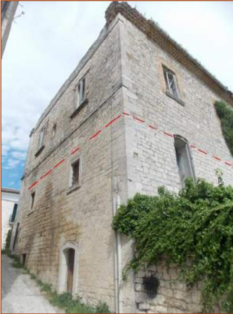
Fig.4. la linea rossa tratteggiata evidenzia il limite orizzontale tra due differenti modi di lavorazione e messa in posa delle pietre nei corsi murari del lato corto ovest
