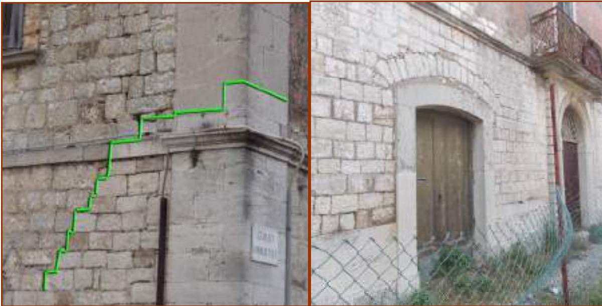
Fig.3. a sinistra con la linea verde si segna il confine tra due differenti modi di lavorazione della pietra, peraltro contraddistinta anche da tonalità di colore diverso; a destra particolare della trama muraria lapidea in facciata.
