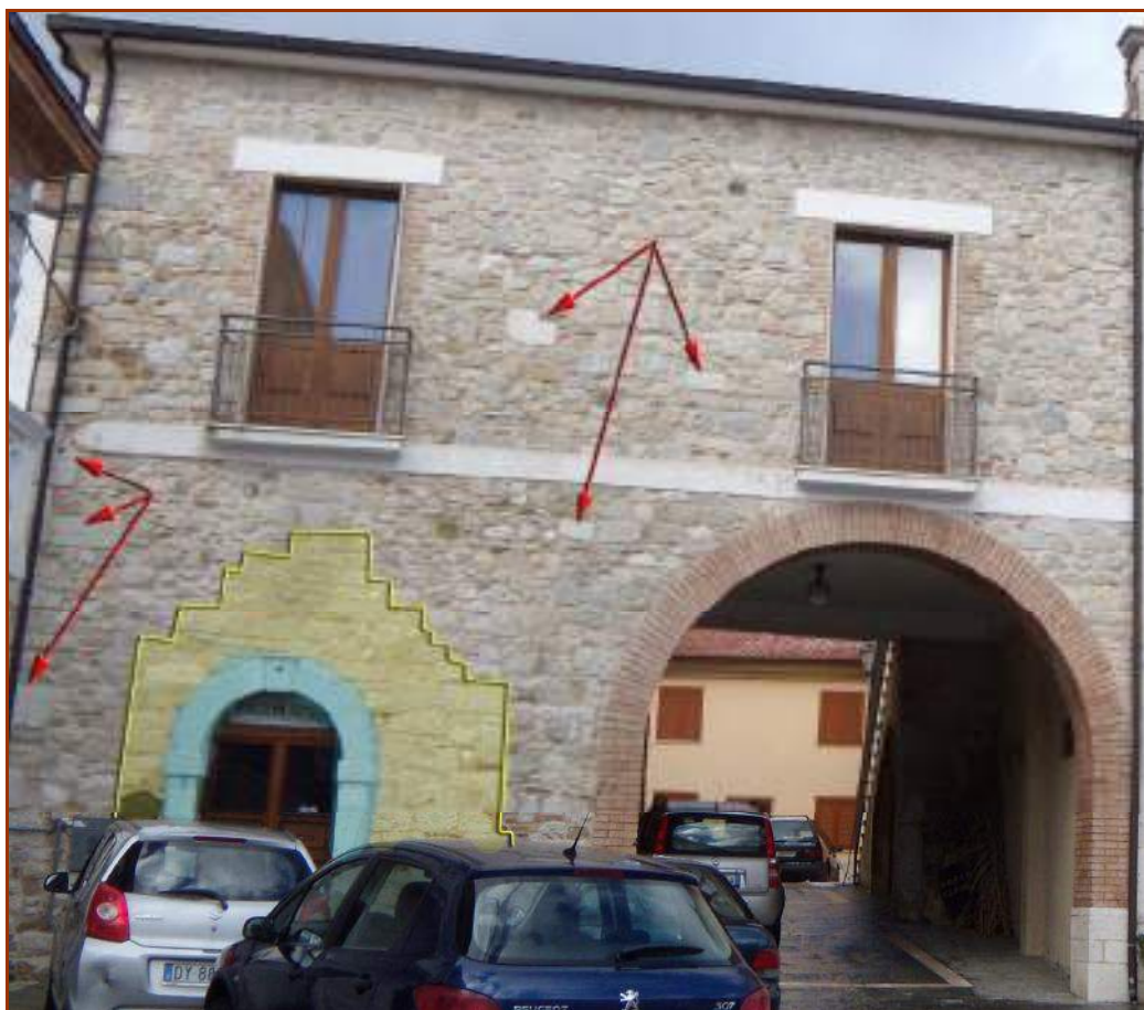
Fig. 2. il prospetto caratterizzato da una fase muraria in blocchetti calcarei evidenziata col giallo. In azzurro il portale inserito datato 1877, mentre con le frecce rosse si evidenziano alcuni elementi di recupero inseriti nella nuova muratura.
