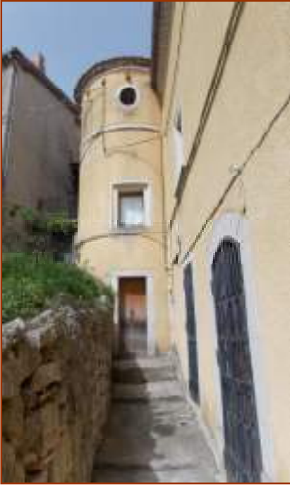
Fig. 4. il corpo di fabbrica cilindrico
