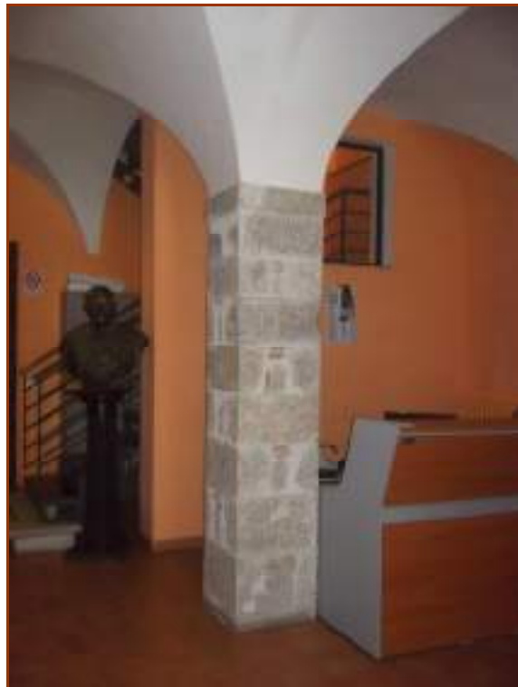
Fig.6. Il pilastro dell'atrio che regge le volte
