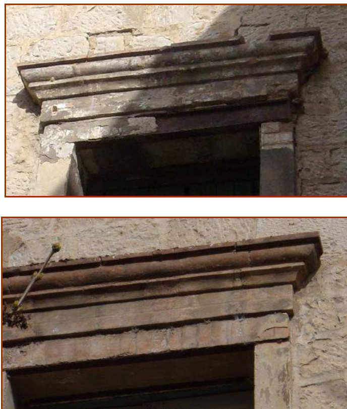
Fig.4. Sopra: il distacco di intonaco evidenzia la presenza del ferro. Sotto: intonaco imitante i mattoni nasconde la struttura portante in ferro dell'architrave.
