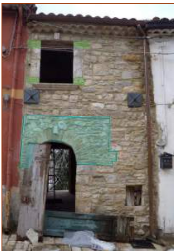
Fig.3. prospetto della facciata con evidenziato in azzurro la tessitura muraria realizzata con scaglie lapidee inserite in modo "caotico" nel muro, mentre in verde si evidenziano gli ampliamenti della finestra eseguiti con l'inserimento di mattoni.
