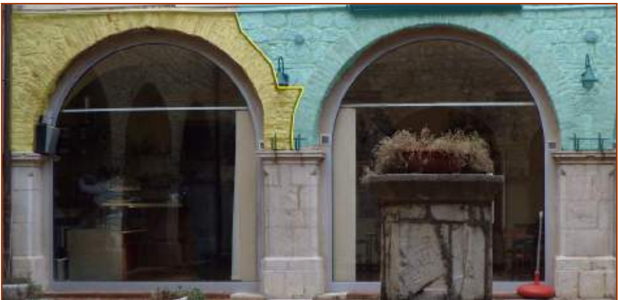
Fig.4. particolare delle arcate di una lato del cortile: in azzurro la fase costruttiva più recente si “appoggia” a quella più antica evidenziata col giallo. Quest’ultima presenta arcate laterizie meno conservate rispetto a quelle della fase azzurra.
