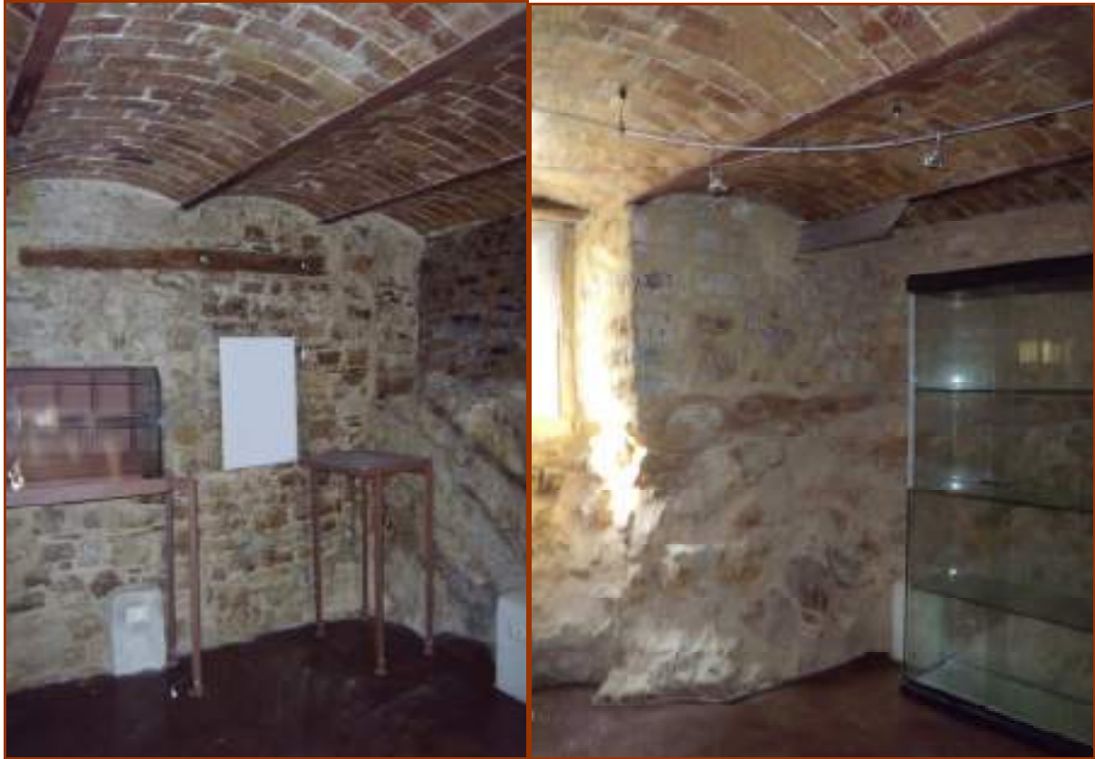
Fig.4. alcuni dettagli degli ambienti seminterrati, coperti da tipici “plaffoni”
