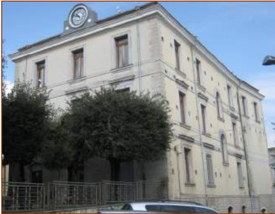
Fig.2. Prospetto del palazzo
