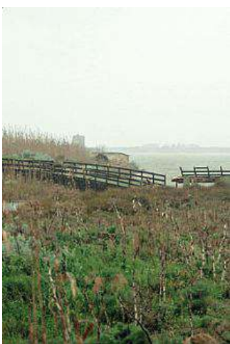
Il ponticello crollato
