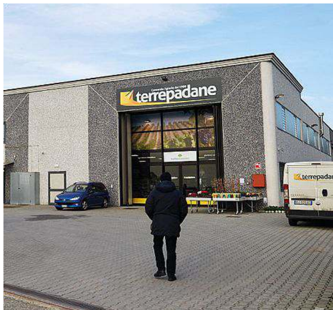
La nuova struttura di Terrepadane a Broni
