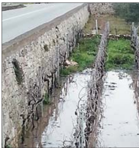
In queste foto le condizioni davvero incredibili nell'area della statale 172 al centro dei provvedimenti della magistratura
