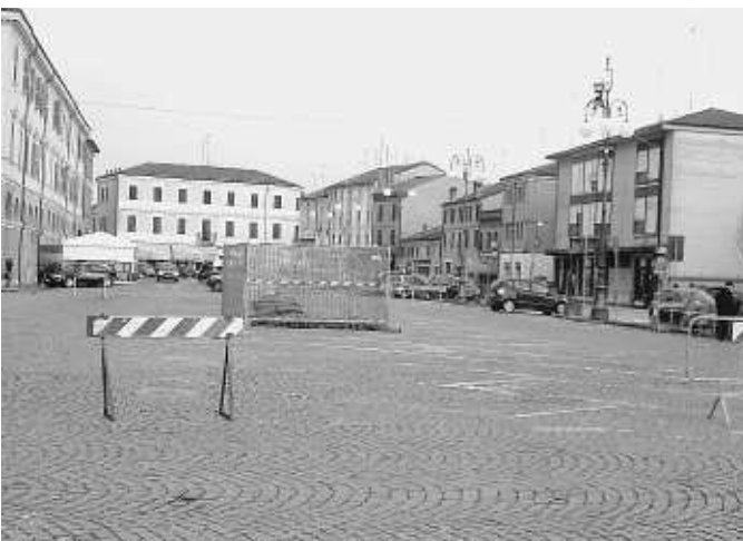
La piazza interessata dai lavori
